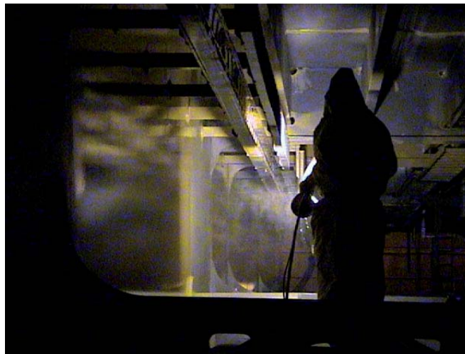
Prüfarbeiten in einer Doppelhüllen-Leerzelle Foto: Luminous Technologies
